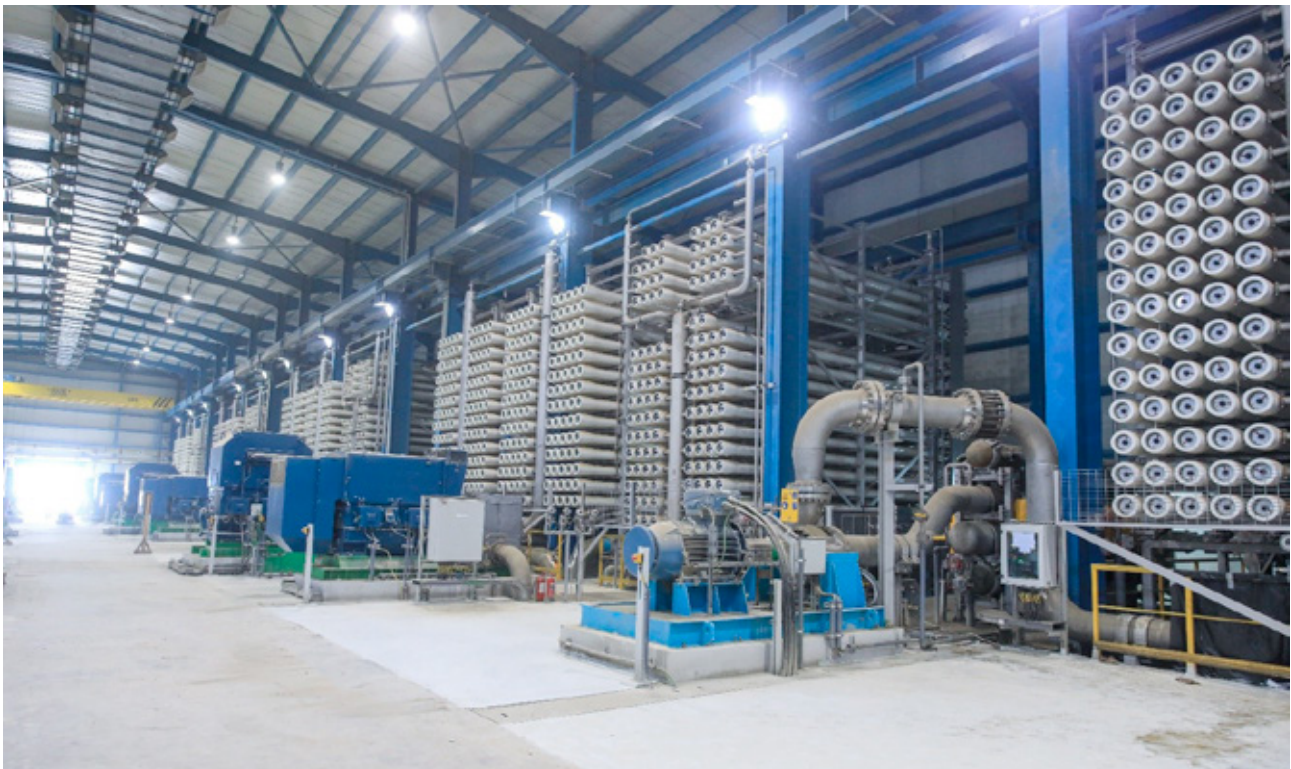
RO Building SHUAIBAH 3 EXPANSION II (Fisia Italimpianti & Abengoa)
