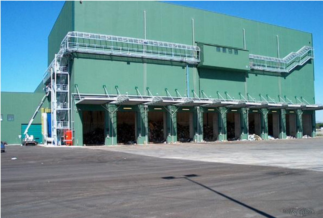
Impianto selezione meccanica rifiuti (STIR-Caivano)
