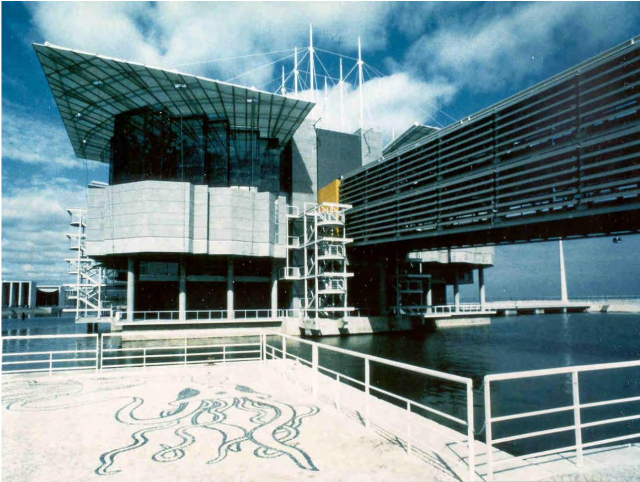
Acquario di Lisbona (Portogallo) veduta da fuori Volume totale delle vasche di esibizione 7,500 m 3
