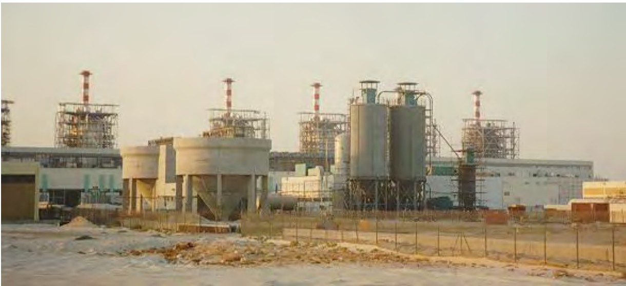
Al Taweelah (UAE) – Impianto di Remineralizzazione con processo “Lime Water” 160 MIGD (30,307 m 3 /h)
