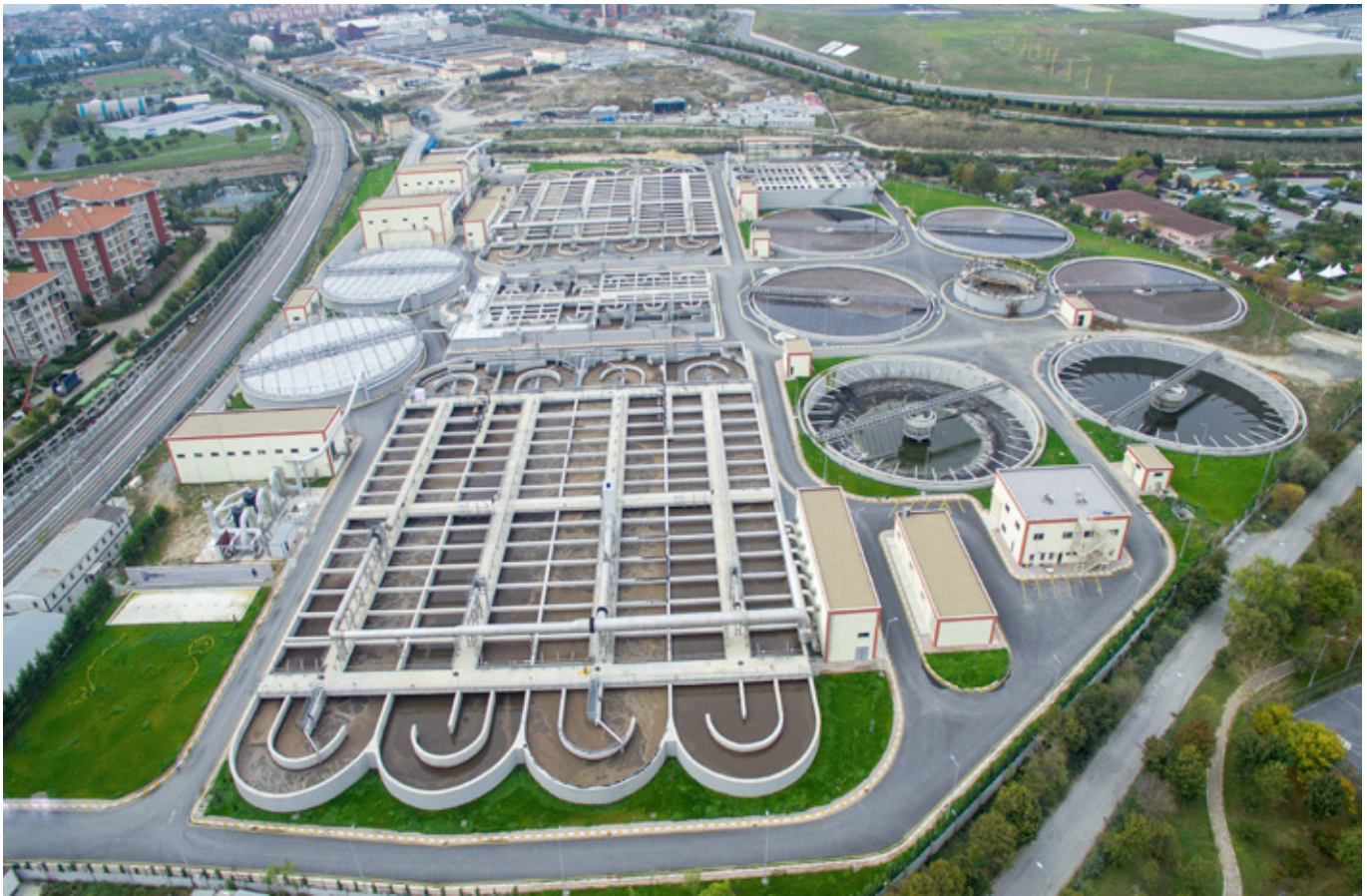
Atakoy WWTP (Fisia & Alkatas, s.d.)
